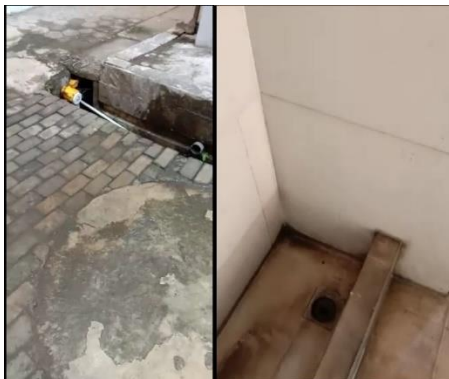
Gambar 3.8 Instalasi pemanfaatan air wudlu untuk penyiraman pohon/tanaman
